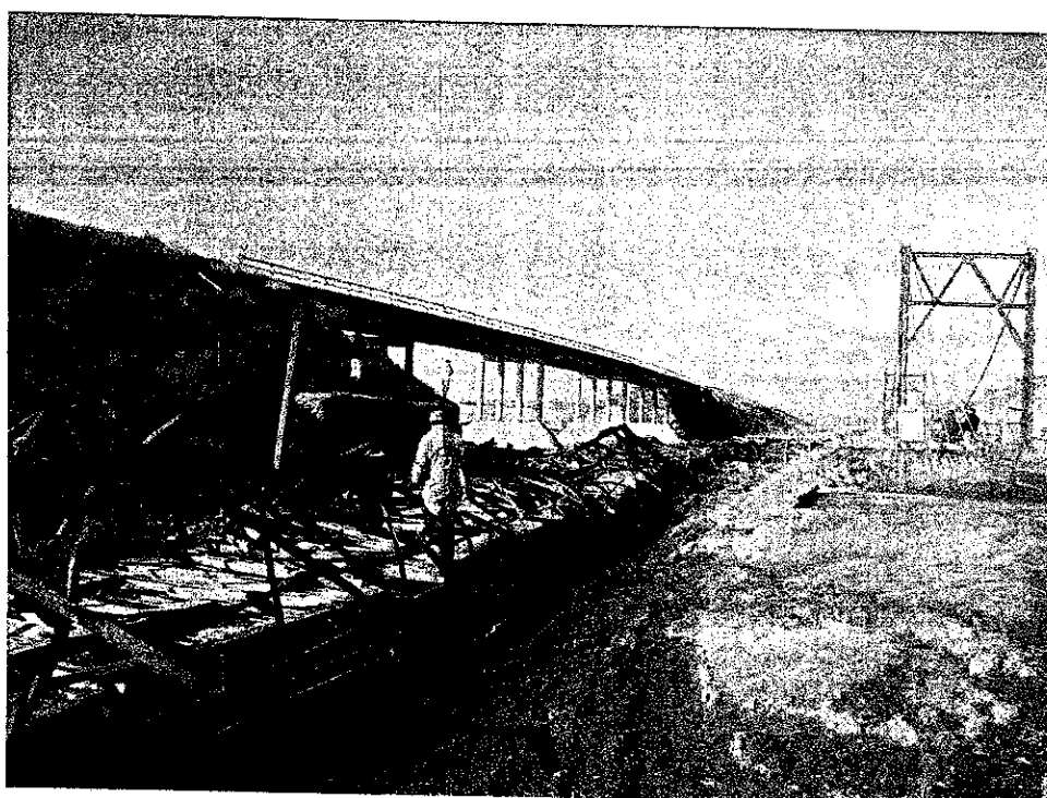
Fotografía N° 3 (restos de la estructura)
